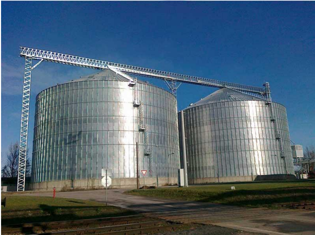
Figura 2: Exemplo de silo metálico.
