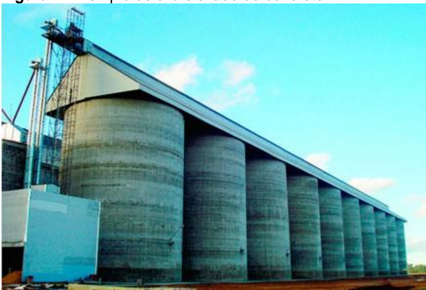
Figura 1: Exemplo de silo elevado de concreto.
