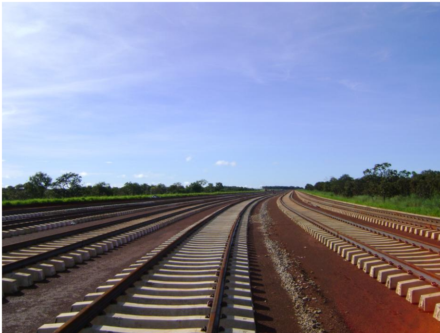
FOTO 3.3 - PÁTIO FERROVIÁRIO DE PORTO NACIONAL
