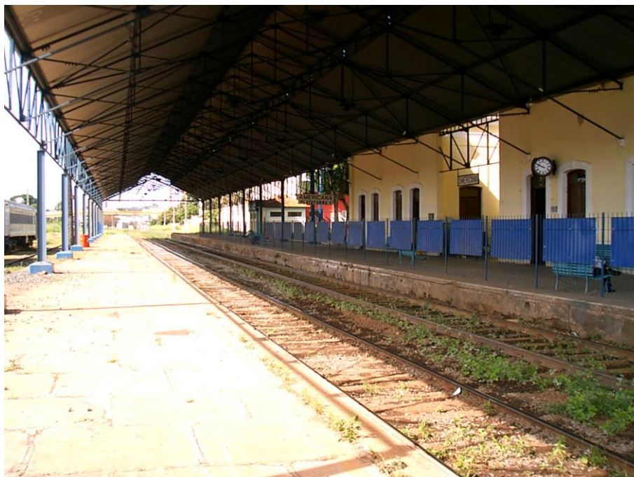
FOTO 2.3 – ESTAÇÃO FERROVIÁRIA DE AMERICANA (SP)
