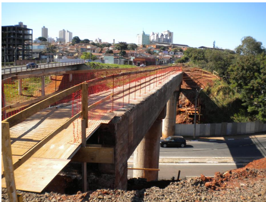
FOTO 2.2 – VIADUTO DA ANTIGA COMPANHIA PAULISTA DE ESTRADAS DE FERRO – PIRACICABA (SP)
