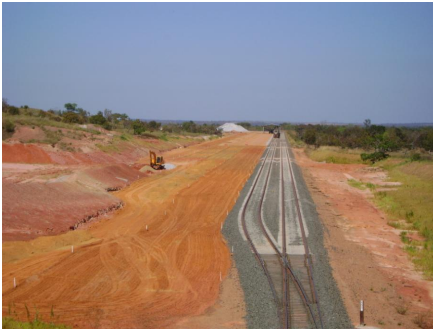
FOTO 3.1 - PÁTIO FERROVIÁRIO DE COLINAS
