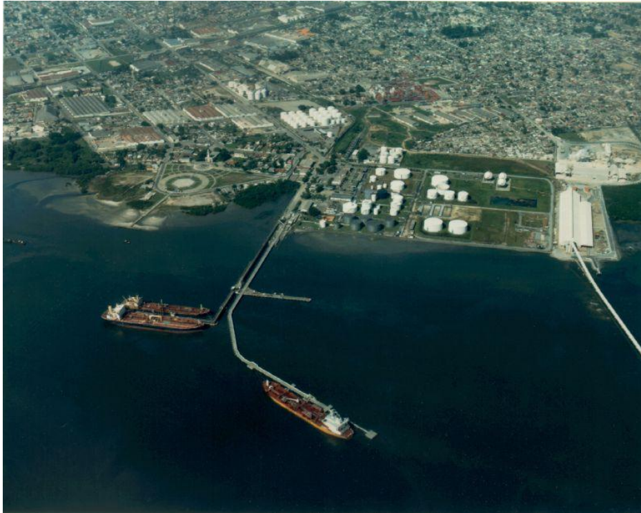
Figura 16: Vista Aérea do Porto de Paranaguá Fonte: APPA (2013)
