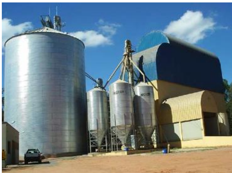
Figura 11. Unidade armazenadora com três silos-pulmão.
