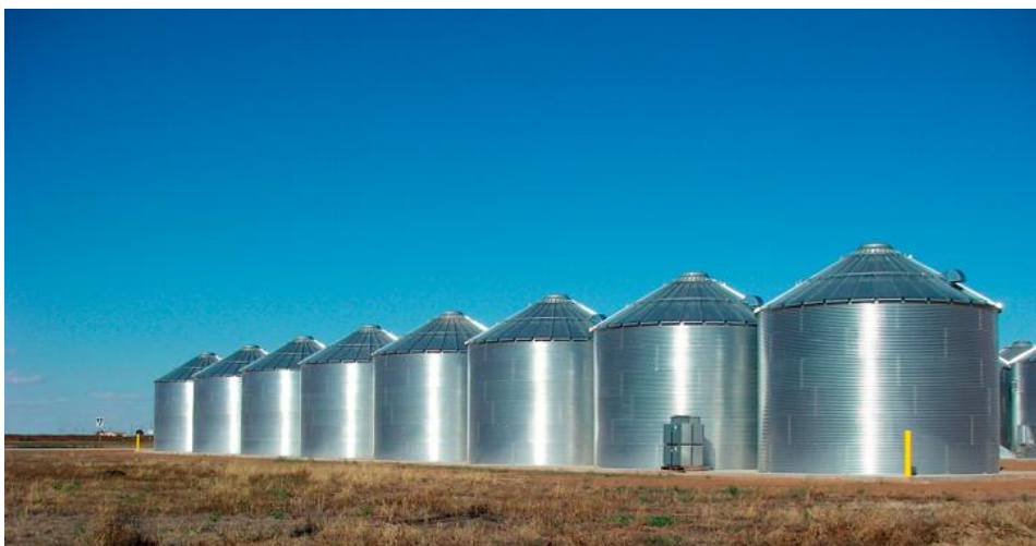
Figura 3. Bateria de silos horizontais em chapa metálica com fundo plano. Fonte: Argus, 2013.
