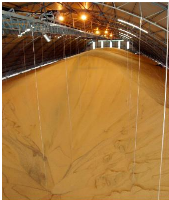
Figura 5. Interior de armazém fundo "V" com detalhes dos cabos do sistema de termometria. Fonte: COAMO Agroindustrial Cooperativa, 2013.
