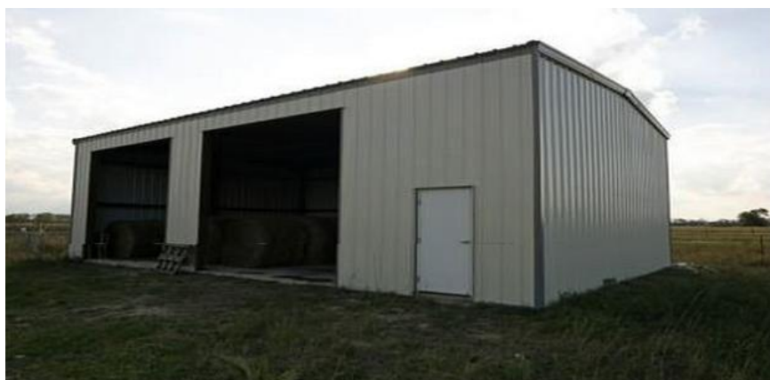
Figura 14. Galpão confeccionado por chapa de aço. Fonte: Dacheng, 2013.
