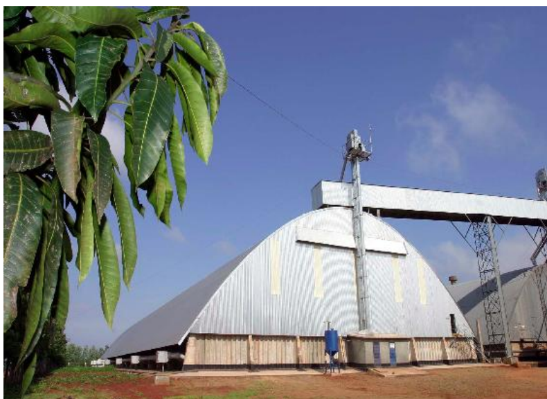
Figura 4. Silo horizontal ou armazém graneleiro.
