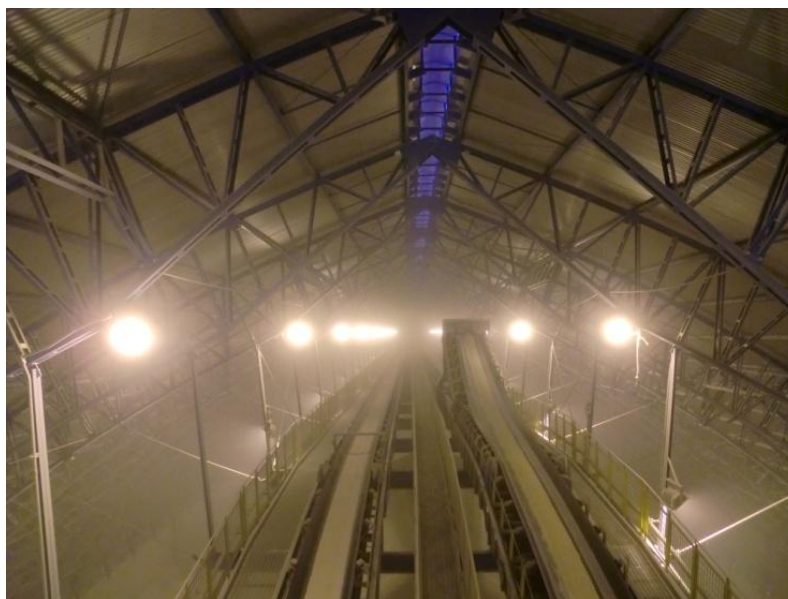
Figura 8. Visão geral do interior do armazém.
