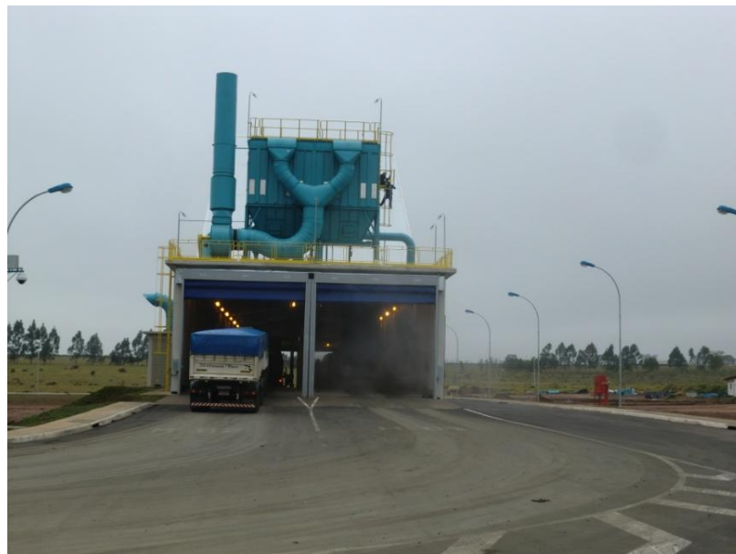
Figura 6. Moega para descarga dos veículos.
