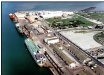
Figura 8. Área de Contêineres do Porto Novo
