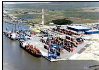
Figura 20. Terminal Tecon Rio Grande do Superporto
