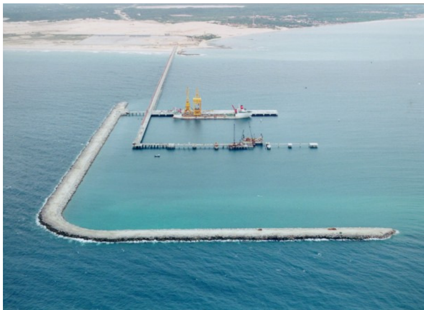
Figura 6. Terminal portuário "Off-Shore" (Porto de Pecém)
