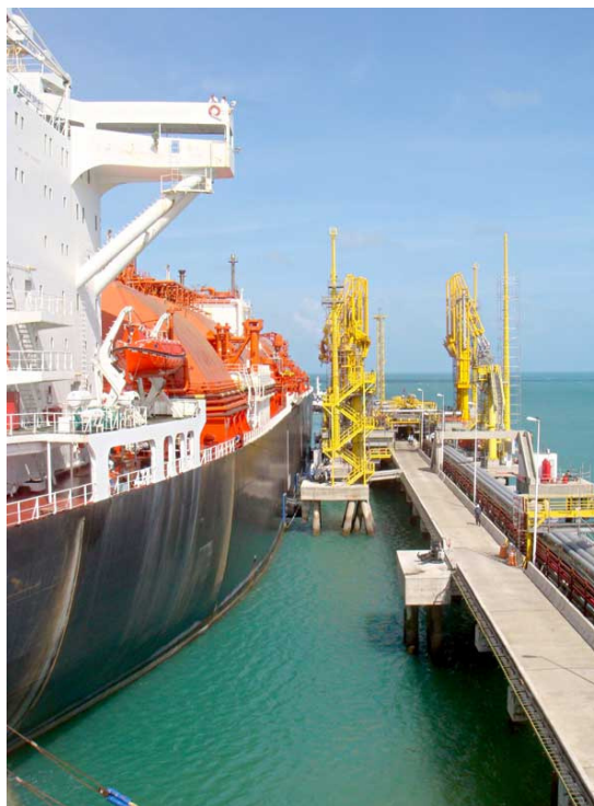
Figura 12. Navio com GNL chegando ao Porto de Pecém para abastecer o terminal de regaseificação no local
