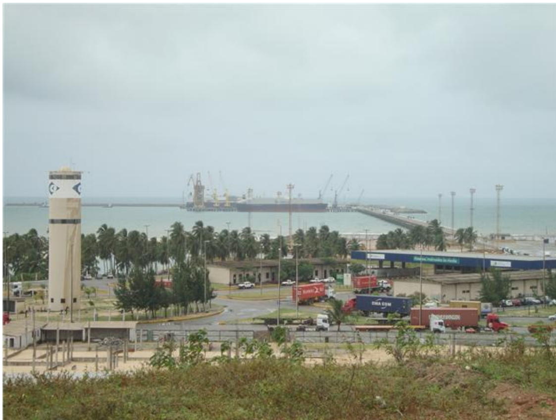
Figura 2. Vista Geral do Porto de Pecém
